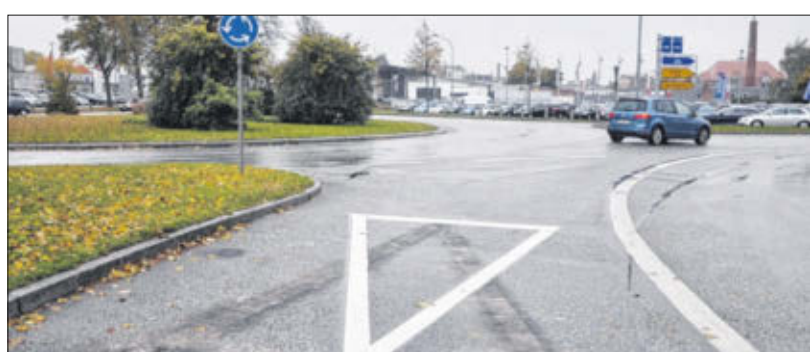
In der Straße bei der Lohmühle wurde das Verkehrszeichen 205 (Vorfahrt gewähren) falsch aufgemalt. Die Markierungsfirma hat das Dreieck inzwischen übermalt und korrekt platziert. Foto: Holger Kröger
